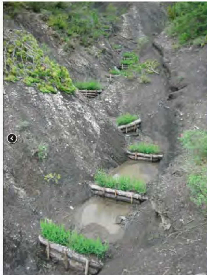
Ejemplo de instalacion de troncos para reducir velocidad del agua. El vetiver se debe instalar en medias lunas, subiendo parte del talud para que agua se mantenga en el centro del desagüe.
